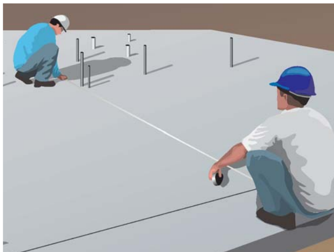
Figura 22 – Marcação das direções da parede
