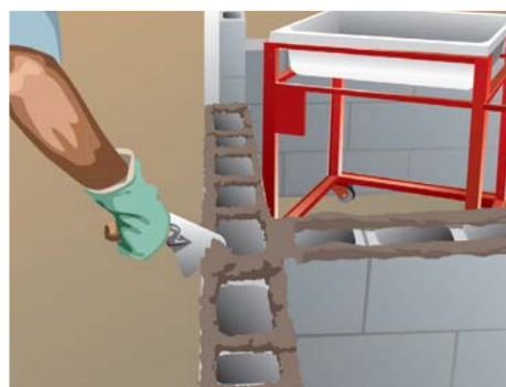
Figura 65 – Aplicação da argamassa nas paredes transversais
