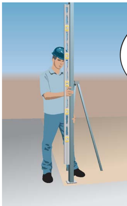
Figura 31 – Aprumando com régua prumo-nível
