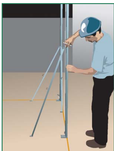
Figura 33 – Transferência da referência de nível
